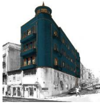
FUNDAÇÃO CUPERTINO MIRANDA
